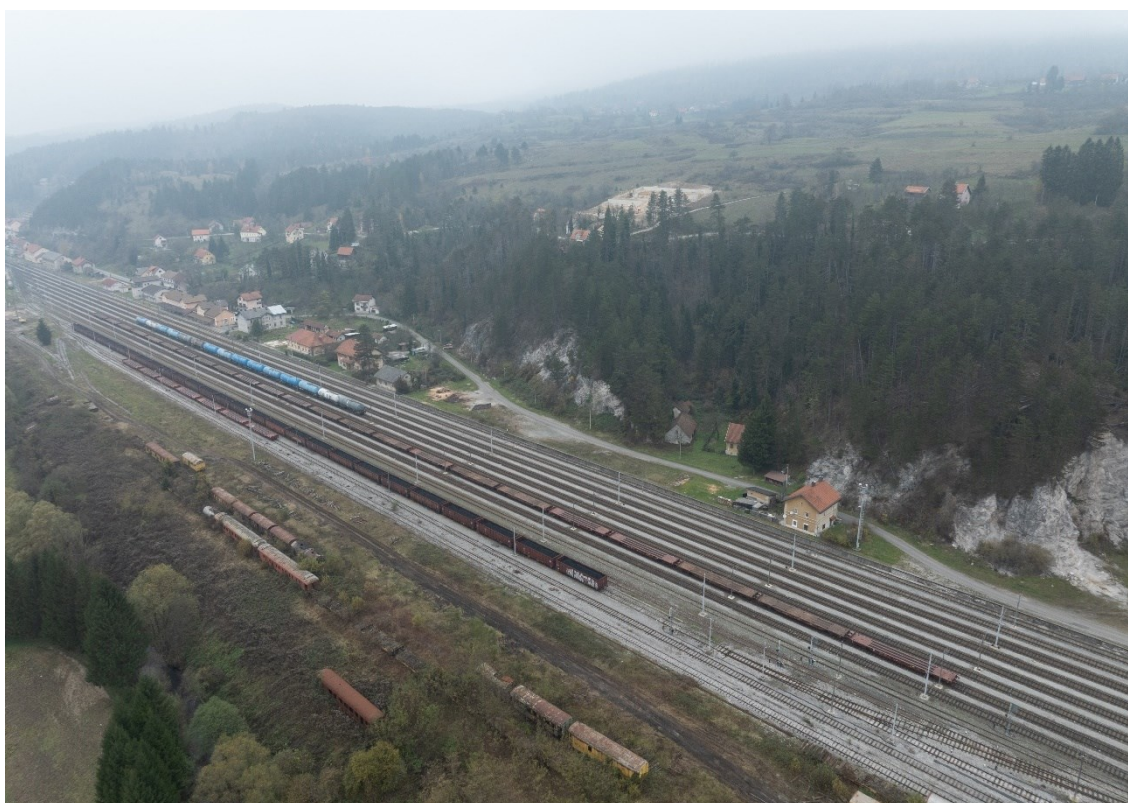
Slika 88 Koridor željezničke i postaja u Moravicama (Autori: 3E PROJEKTI d.o.o. i Andlar)
