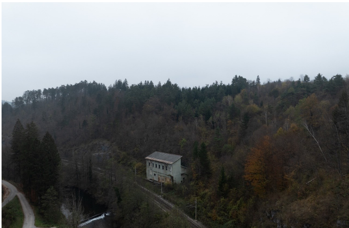
Slika 82 Napušten prostor ložione HŽ (Autori: 3E PROJEKTI d.o.o. i Andlar)
