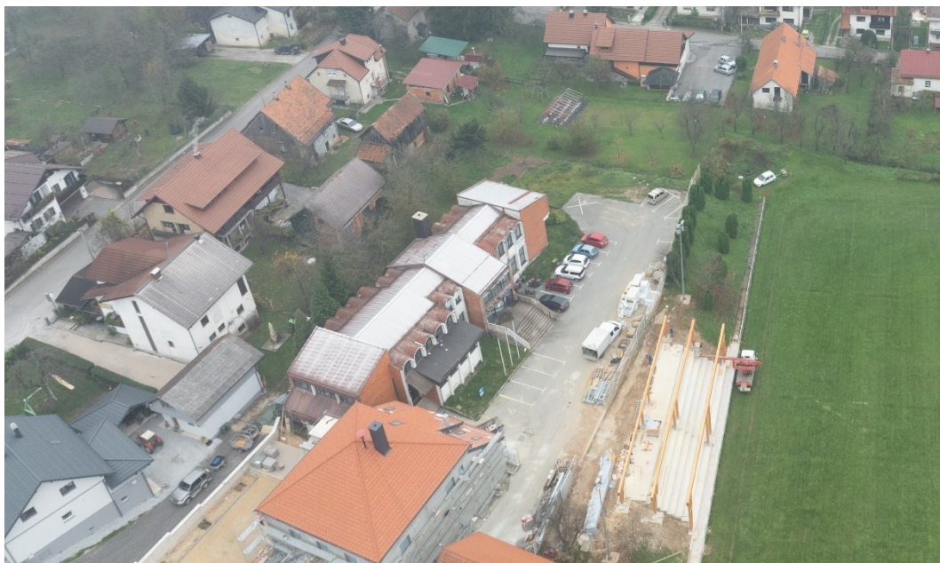
Slika 101 – Administrativna zgrada u Ulici I. G. Kovačića 20/A, Vrbovsko – pogled iz zraka (Autor: 3E PROJEKTI d.o.o. i Goran Andlar)
