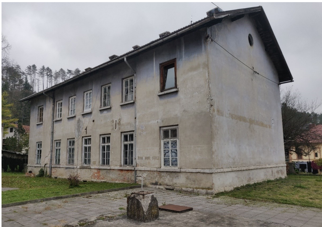
Slika 108 – Zgrada u Moravicama pokraj željezničkog kolodvora u vlasništvu Republike Hrvatske (Hrvatske željeznice) (Autor: 3E PROJEKTI d.o.o.)
