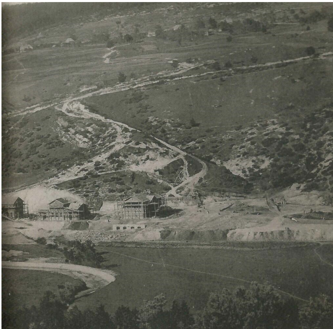
Slika 5 – Izgradnja objekata vezanih uz željeznicu u Moravicama (Željeznička tehnička škola) (Izvor: https://www.novolist.hr/ )
